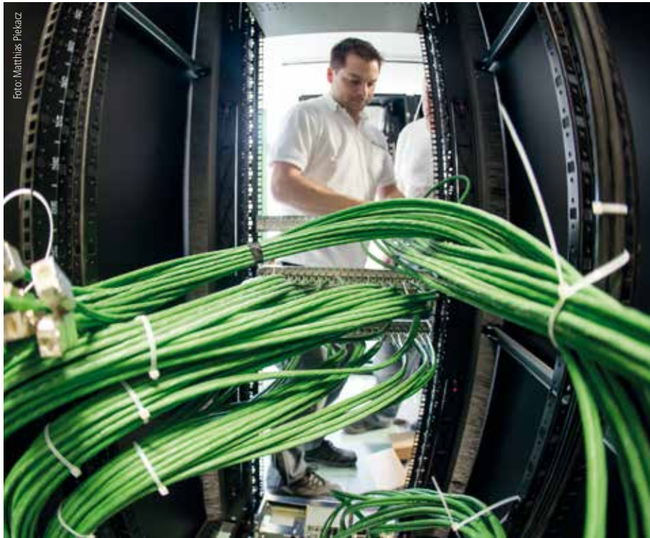
Hinter den Kulissen: Computersysteme, so groß, dass sie ganze Räume füllen. Während der Baumaßnahmen im ZKI wurde ein solches System vom Dach- ins Erdgeschoss verlegt – unter anderem durch Verkabelungsarbeiten von Elektro-Meister Denis Wilke.
