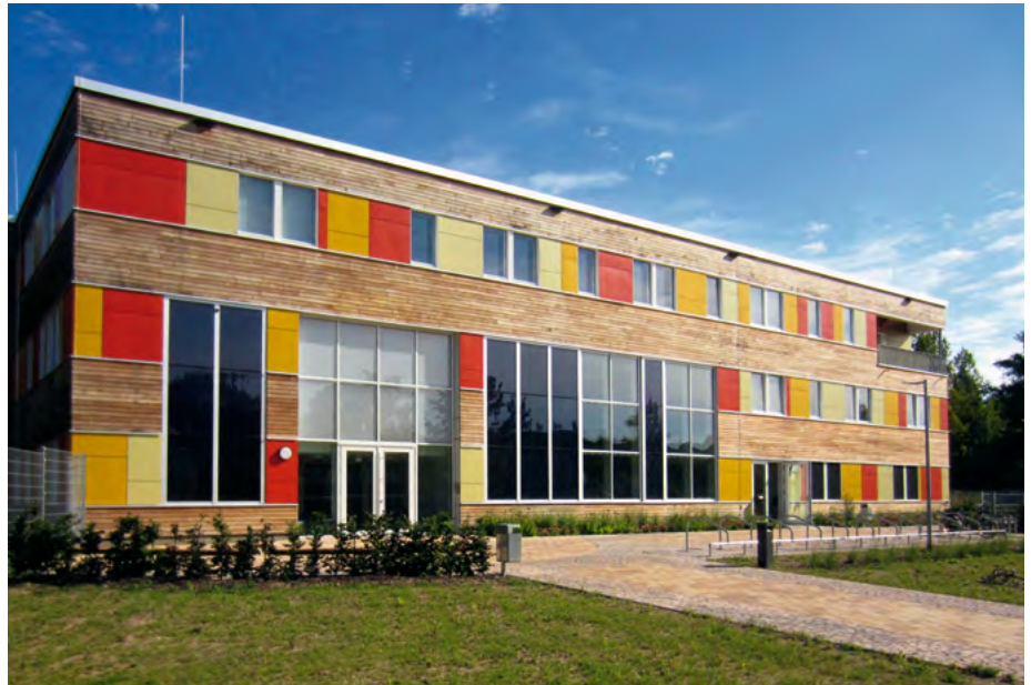
Eine thermische Solaranlage in der Fassade der St. Franziskus Grundschule liefert Wärme.
